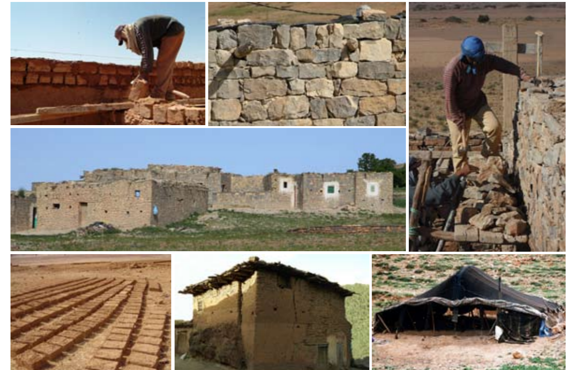
Types d'habitat et techniques de construction traditionnelles du Moyen Atlas
