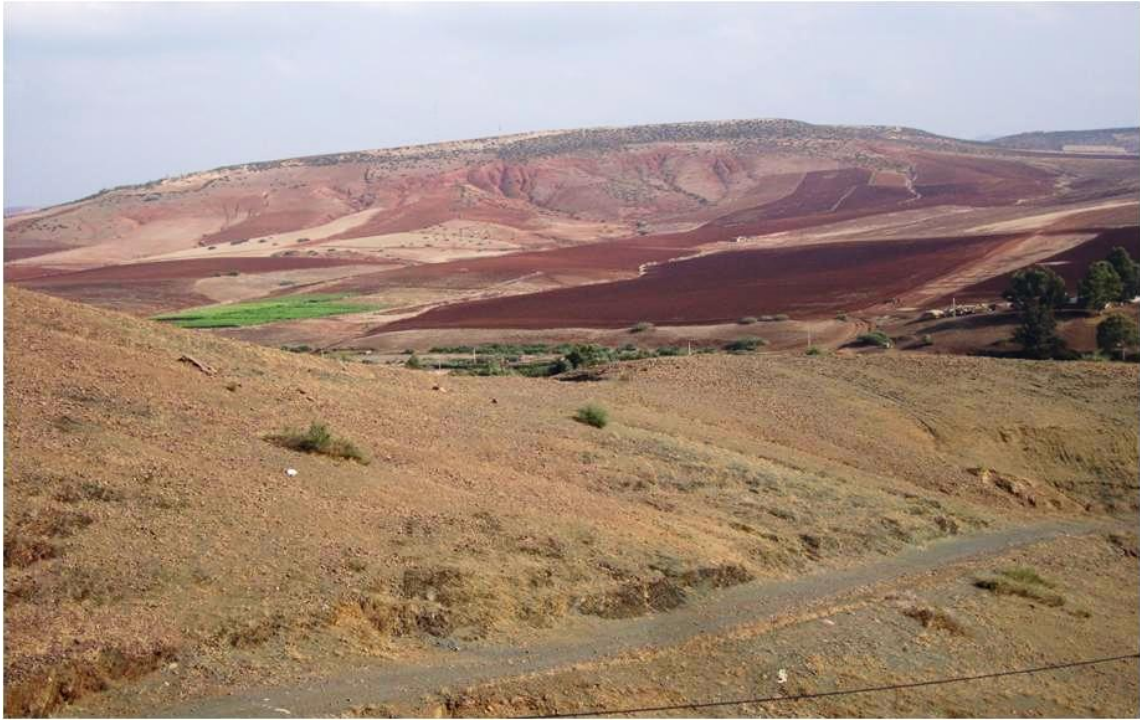
FIGURE 7.15: Le compartiment effondré au sud de l'Oued El Malha
