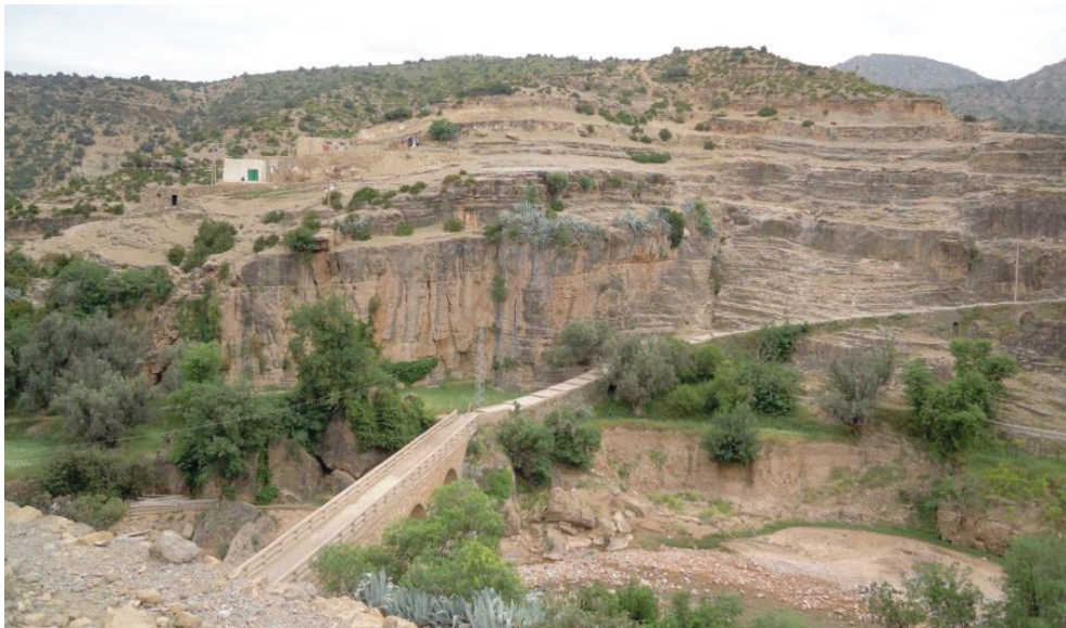
Fig. 8 - Il ponte in muratura dal quale si diparte l'unico sentiero d'accesso all'abitato di Taferdoust che si sviluppa lungo uno scosceso versante a gradinata intagliato nel calcare cornice.
