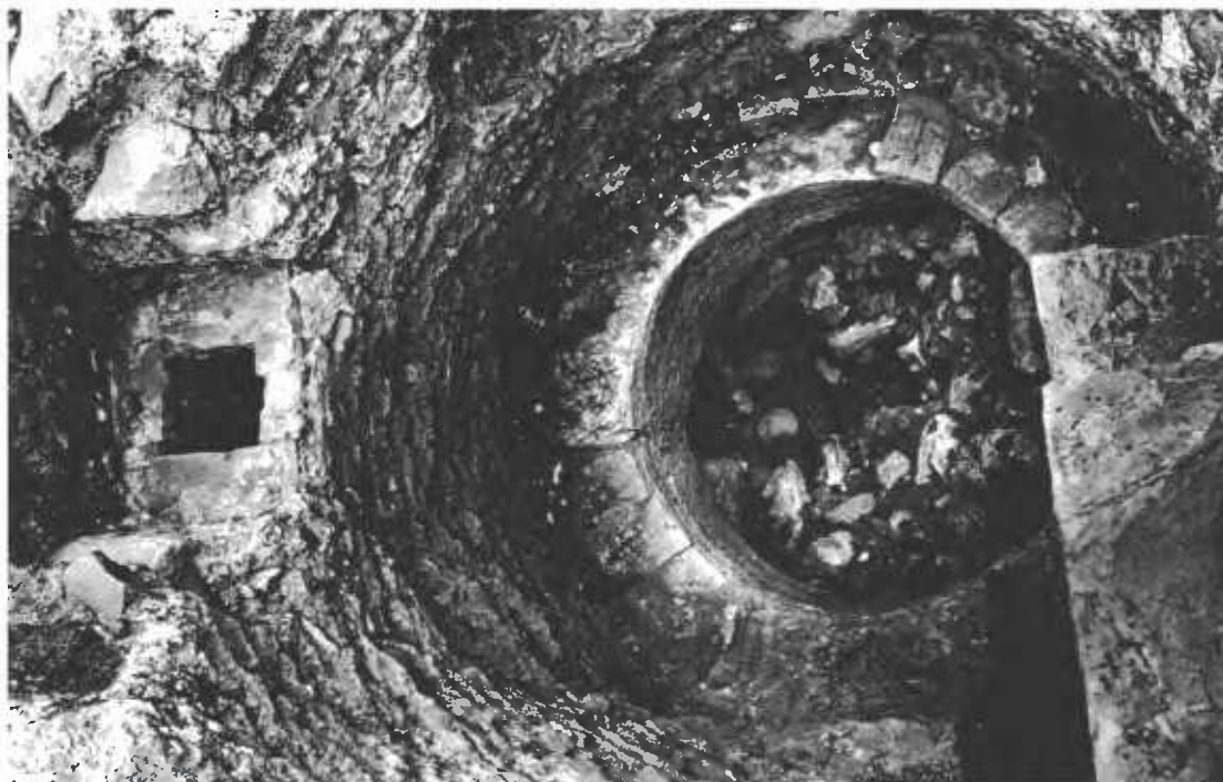
Fig. 20 : La cuve du roudet immergé de Chemtou. A droite l'extrémité du canal d'admission d'eau, en sifflet. A gauche, la partie supérieure à section carrée de la cheminée contenant le levier trempure, commandant le banc horizontal dont le passage apparaît à droite au fond de la tour circulaire, dont la partie haute a disparu. D'après Röder, Turbinenmühle, 1993, p. 22.
