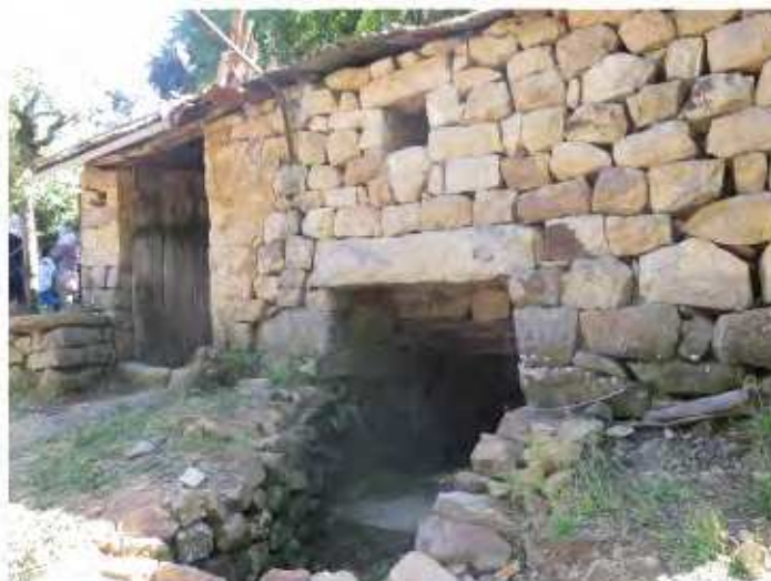
Fig. 1 : La façade du moulin d'Imeghdassen (Kabylie, vallée de la Soummam). Au centre le canal d'évacuation sortant de la chambre d'eau. Au-dessus, la pièce de travail. Cliché J.-P. Laporte, mai 2014.
