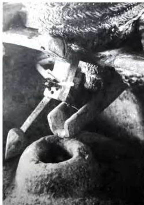
Fig. 14 : Le mécanisme d'alimentation en grain d'un moulin à roudet dans l'Aurès, Cliché Th. Rivière, Aurès 1935 (1978), p. 48, fig. 42. En haut le couffin qui forme trémie ; en bas à gauche, la cheville ouvragée qui frotte sur la meule tournante et produit les secousses nécessaires pour faire couler le grain. Au centre, l'orifice ( tit , l'œil) par lequel le grain entre dans la meule.
